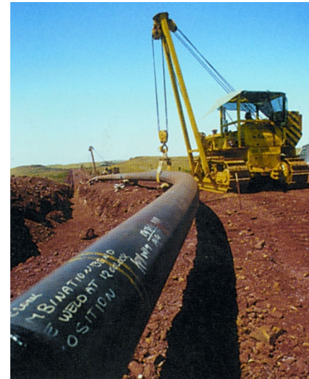
昆州西南部新铺煤气管道，图片承谢Murray Surveyors。
